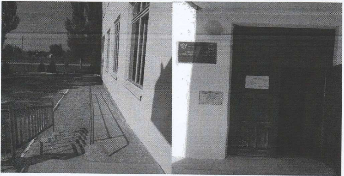
Вход в здание, фото № 4-6
