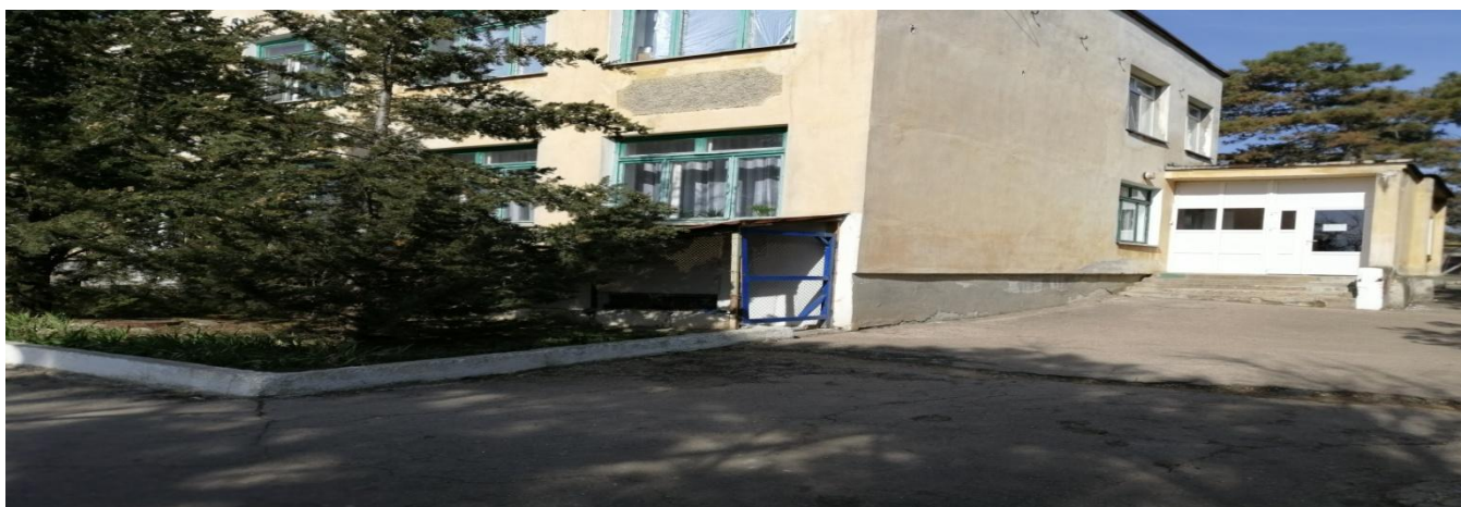
Фото 5.1 Вид на здание со двора
