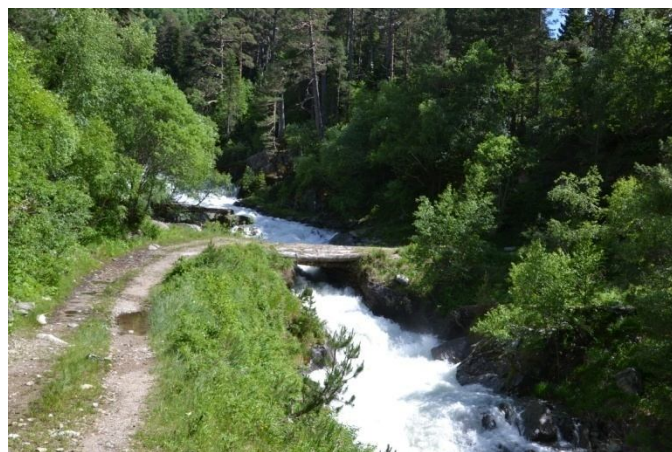
Рис. 28 мост через р.Кти-Теберда
