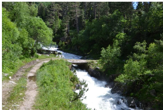
Рис. 28 мост через р.Кти-Теберда
