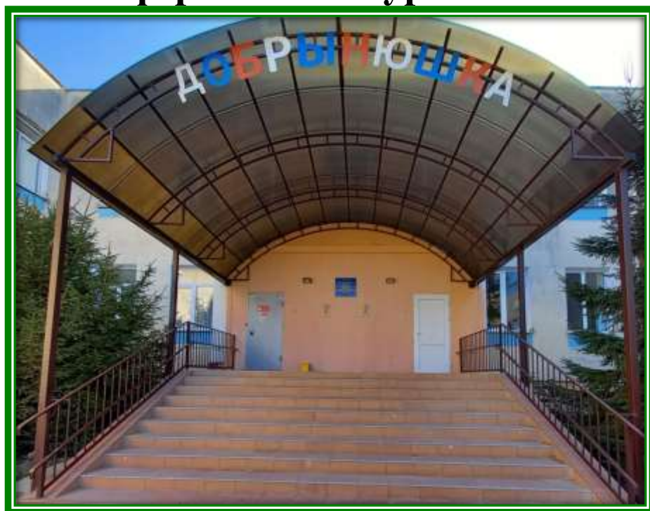
На снимке: здание МБДОУ № 97 «Добрынюшка» г. Симферополь
