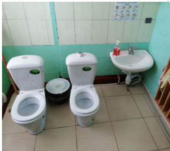
Фото №52 – Санитарно-гигиенические помещения
