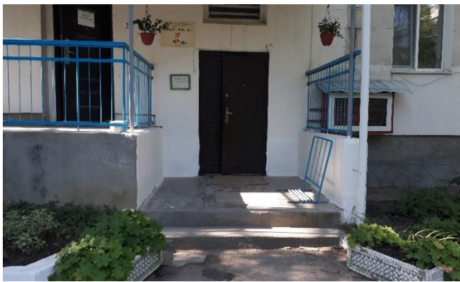
Фото №5 Главный вход подъезд №1
