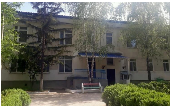
Фото № 25 Общий вид здания
