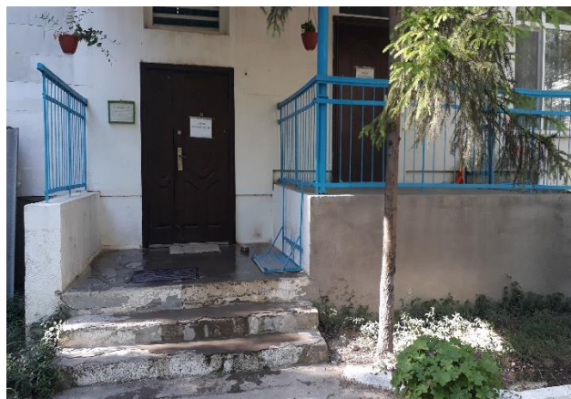
Фото №6 Главный вход подъезд №2
