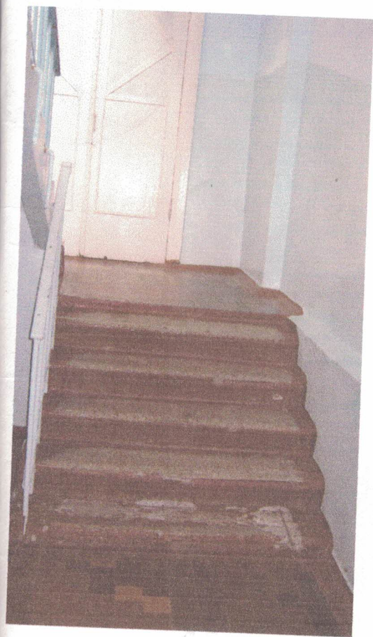
26 Лестница (внутри здания)
