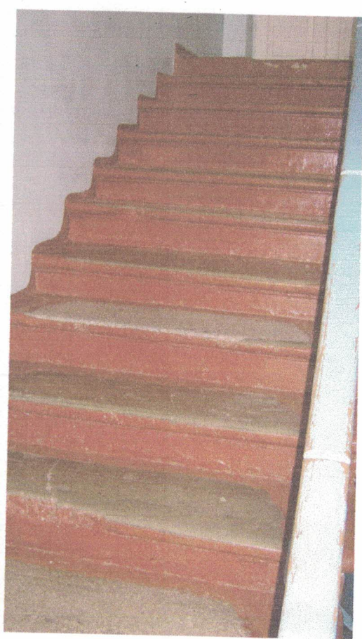
20 Лестница (внутри здания)
