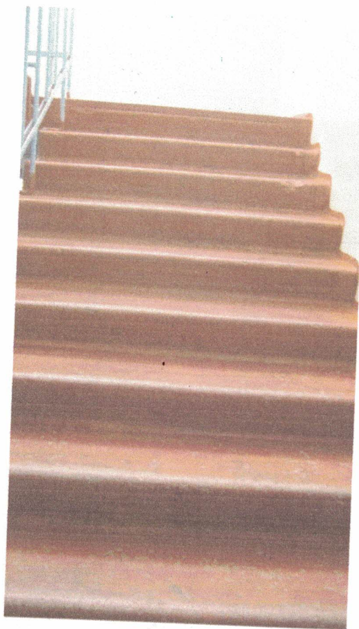
27 Лестница (внутри здания)
