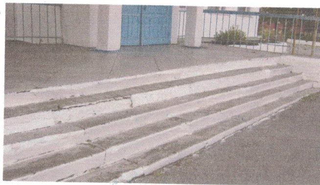
5. Входная площадка (перед дверью)
