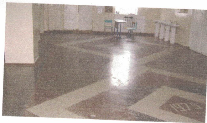
10 Коридор (вестибюль, зона ожидания, галерея, балкон)
