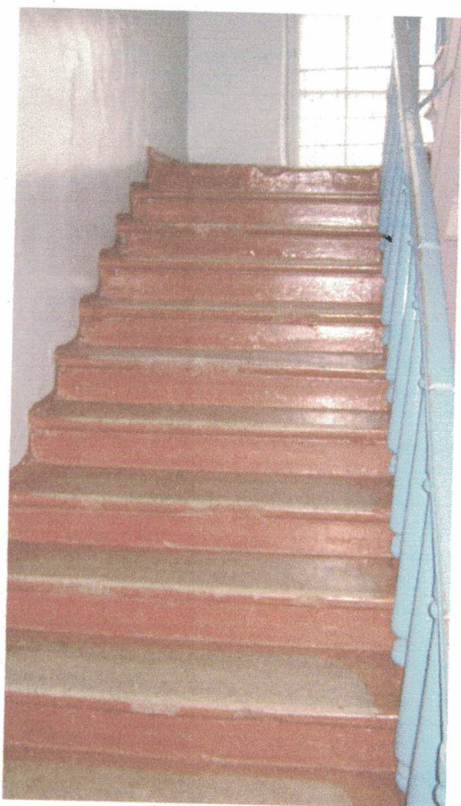
19 Лестница (внутри здания)
