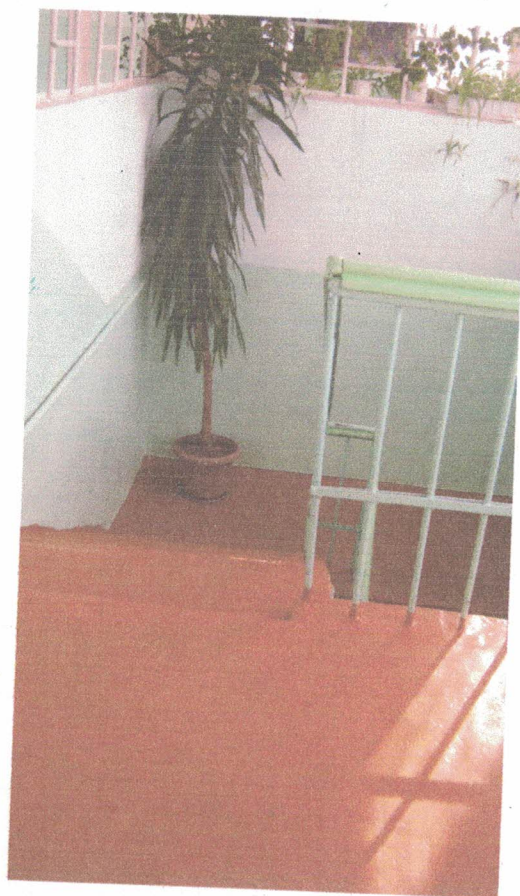
29 Лестница (внутри здания)
