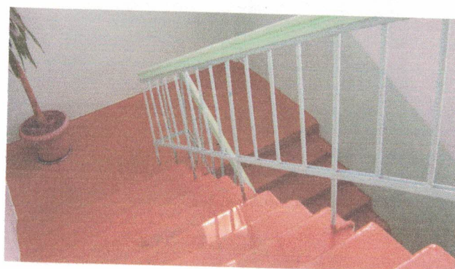
28 Лестница (внутри здания)
