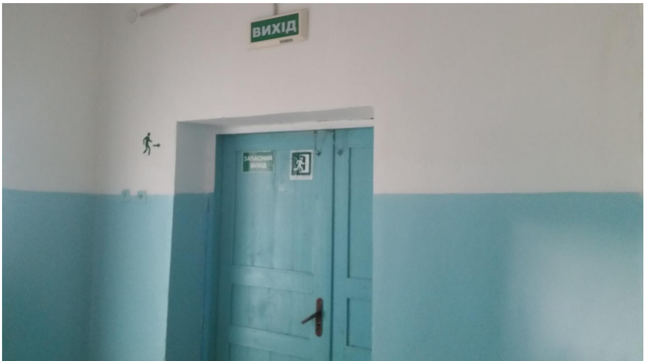
Выход из здания
