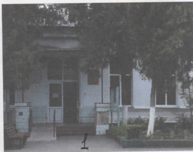
Фото №2 – Вход в здание
