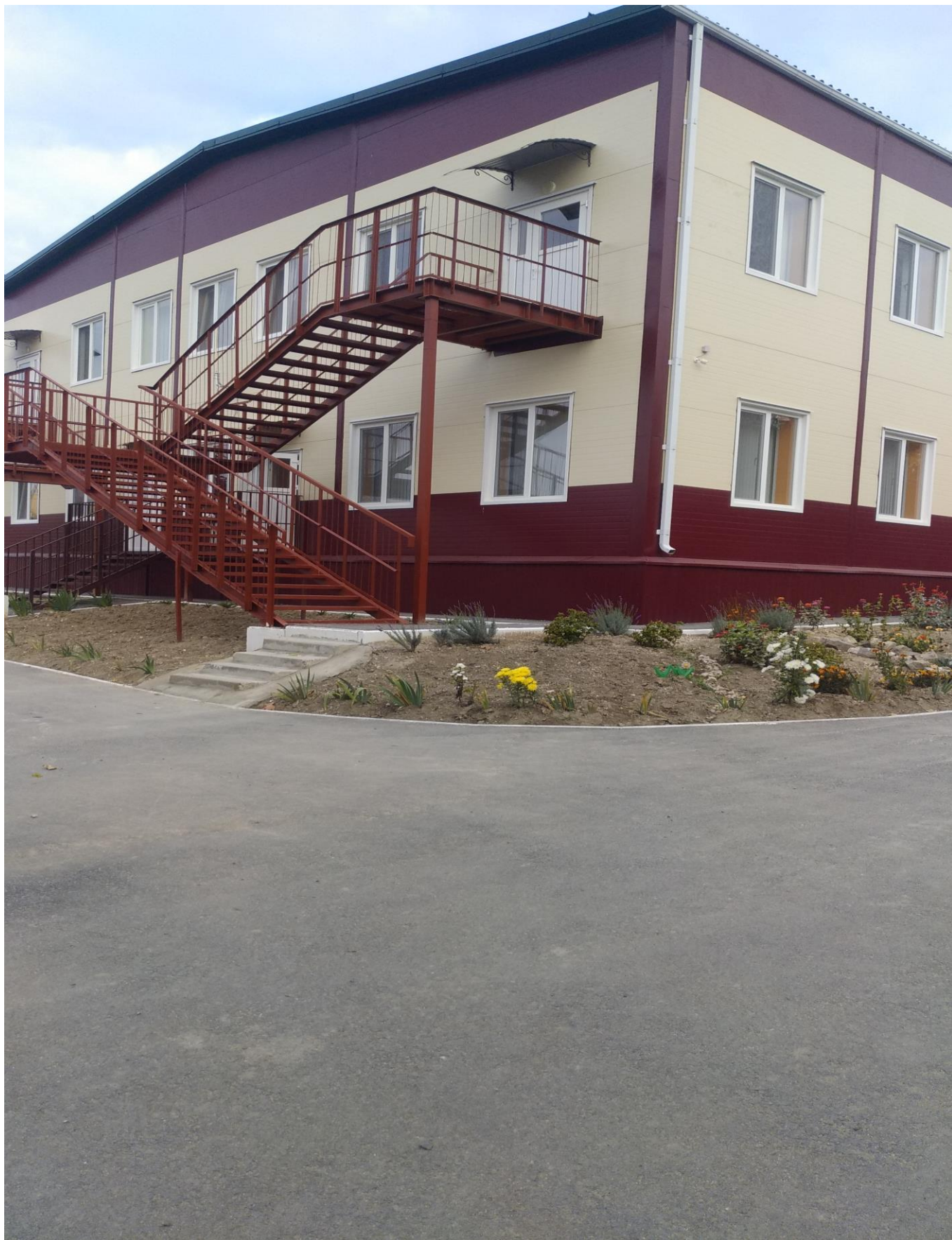
Фото № 5 Вход № 2 МБОУ (ДО) «Железнодорожная СОШ»
