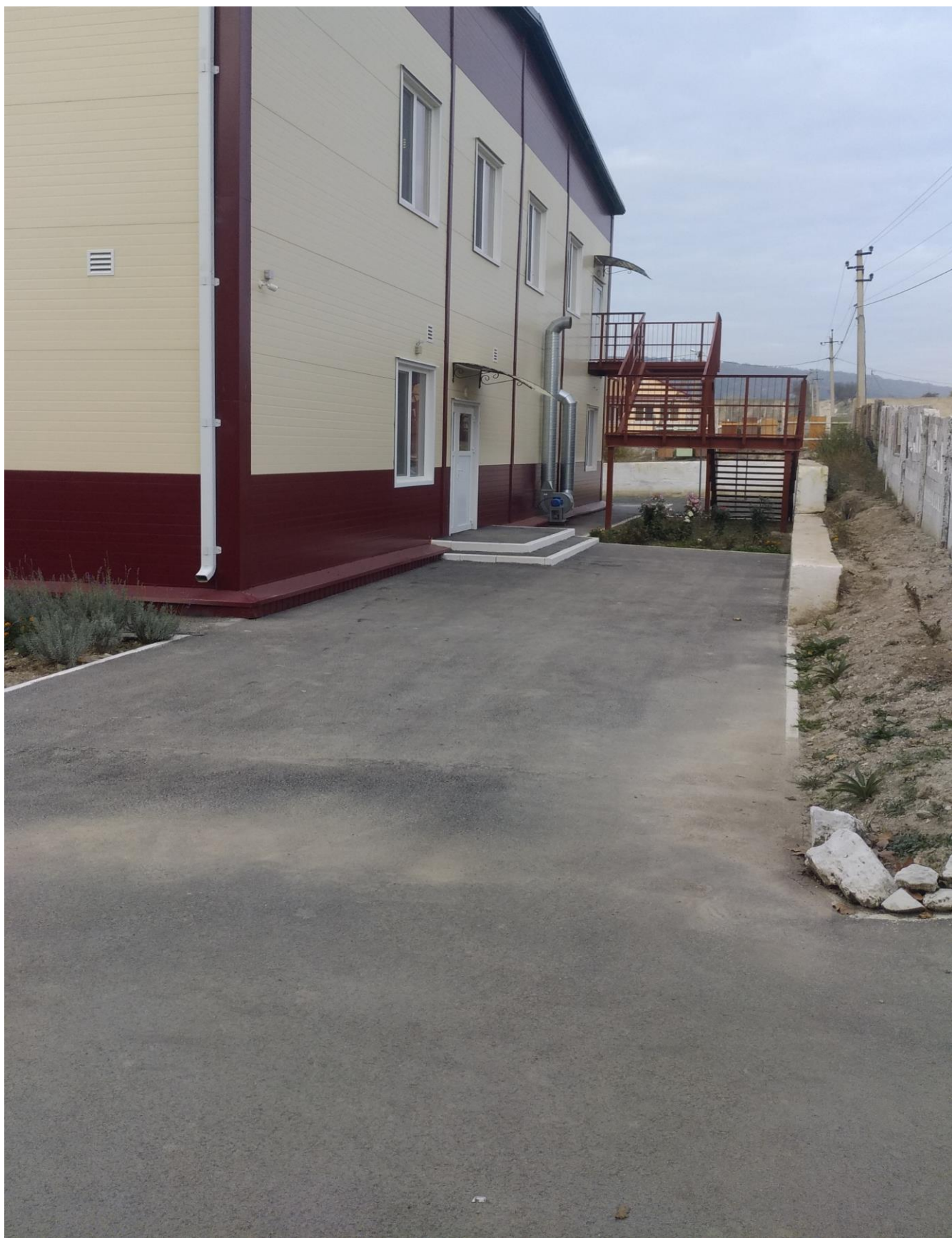
Фото № 4 Вход № 2 МБОУ (ДО) «Железнодорожная СОШ»
