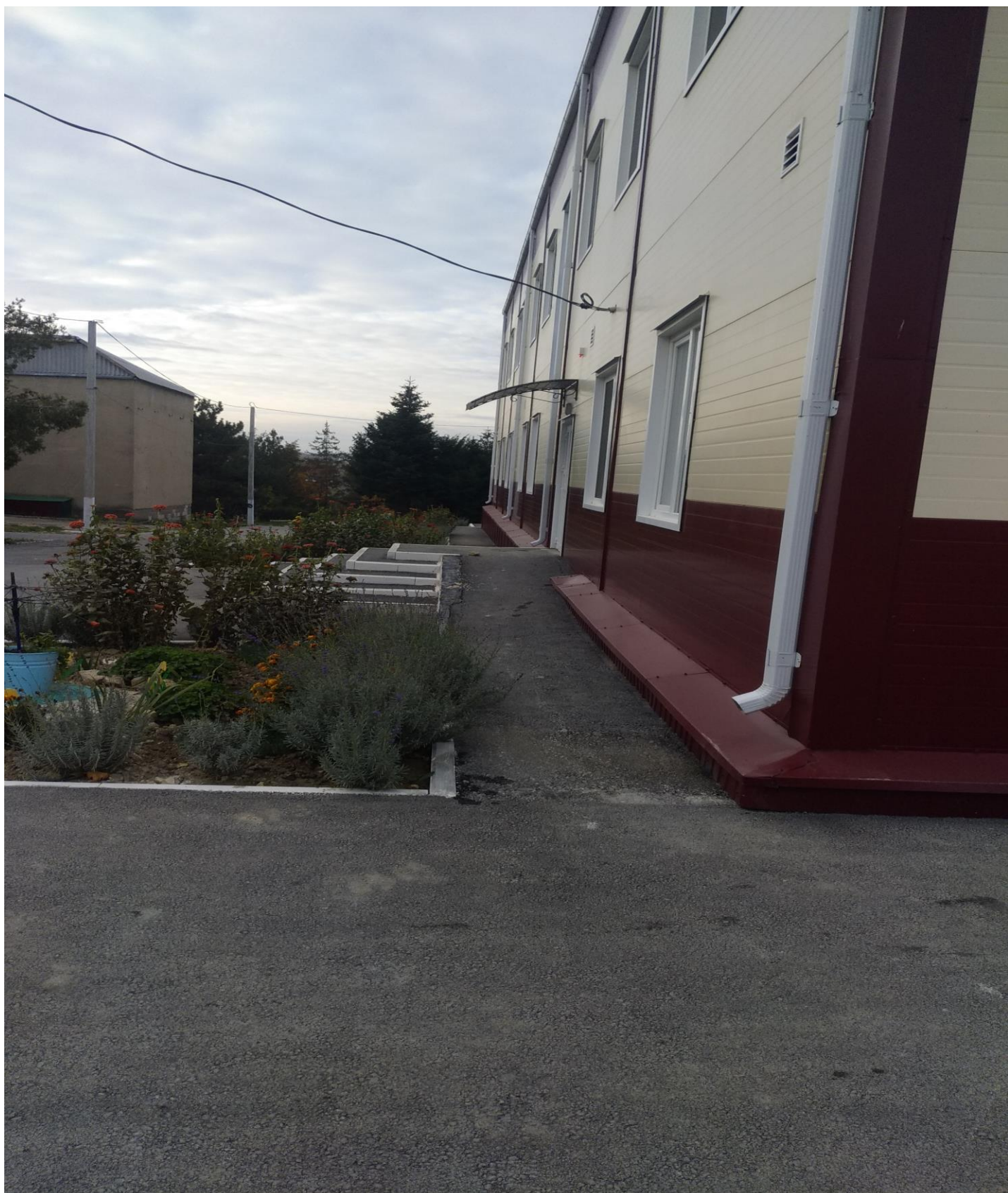
Фото № 6 Вход № 3 МБОУ (ДО) «Железнодорожная СОШ»
