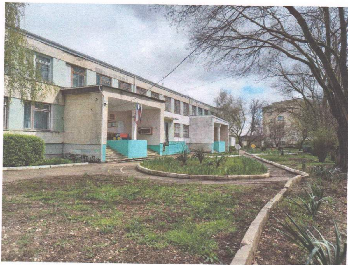
Вид на здание ДОУ от входной калитки
