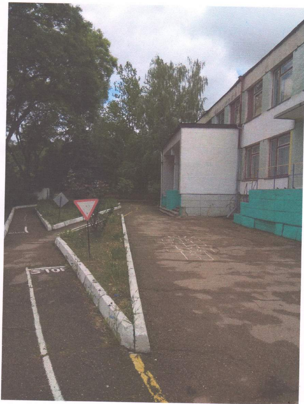
Вид на здание ДОУ от ворот
