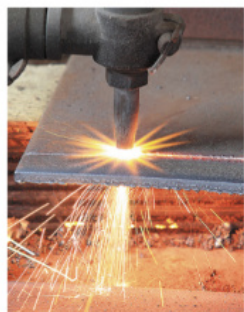
Рис. 2.1. Газовая резка металла
