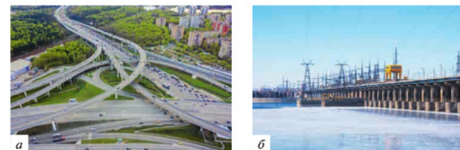
Рис. 2.3. Сооружения: а — транспортная развязка; б — плотина
