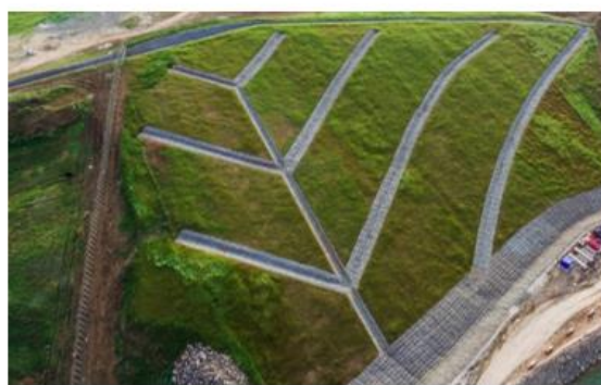
Рис. 8. Осушение оползневого склона
