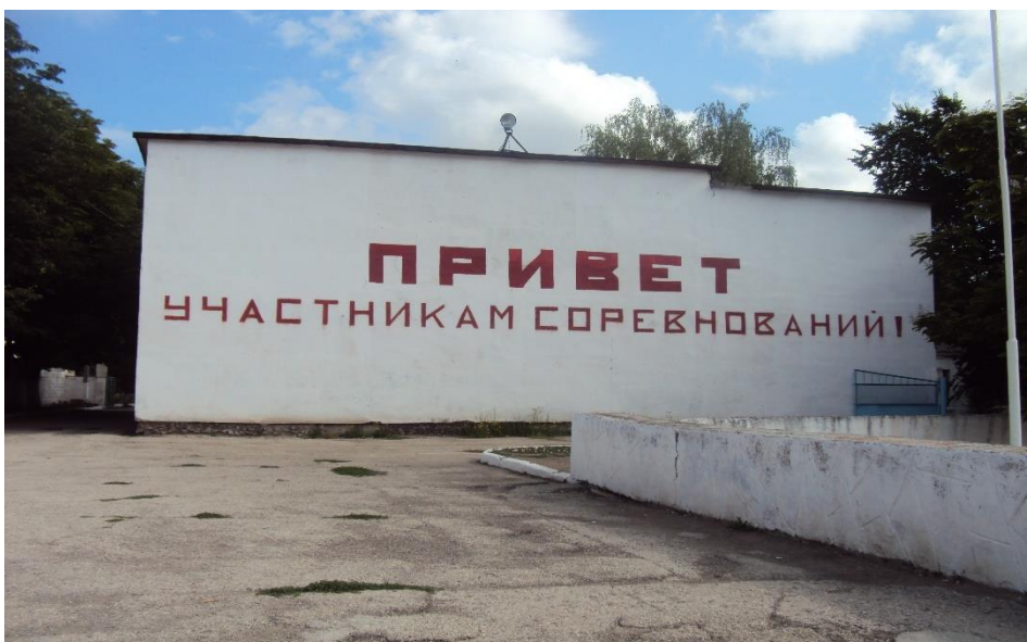
Задний фасад здания МБОУДО "ДЮСШ" Белогорского район
