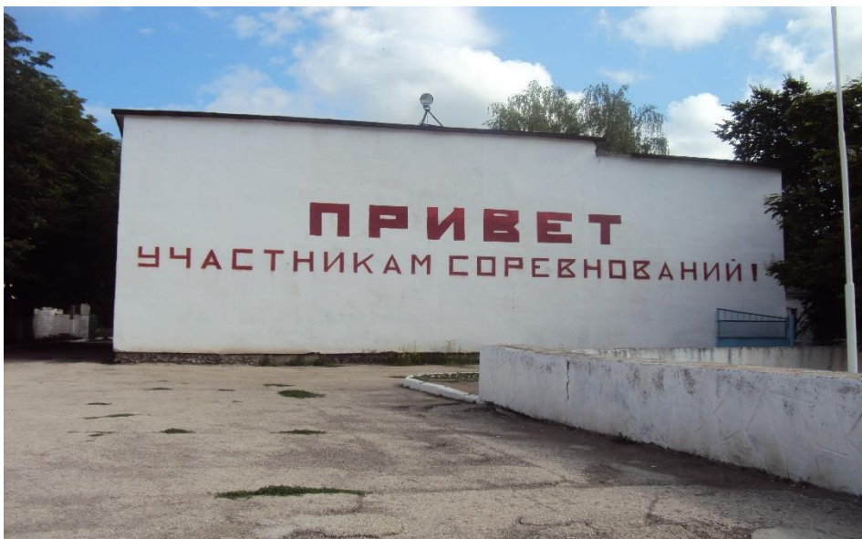
Задний фасад здания МБОУДО "ДЮСШ" Белогорского район
