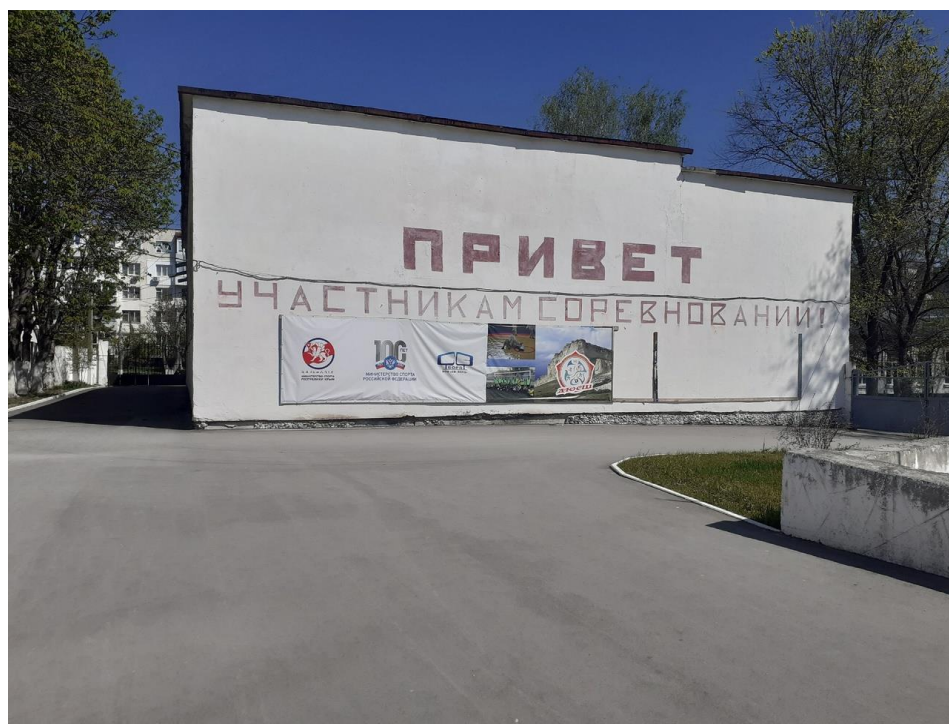
Задний фасад здания МБОУДО "ДЮСШ" Белогорского район
