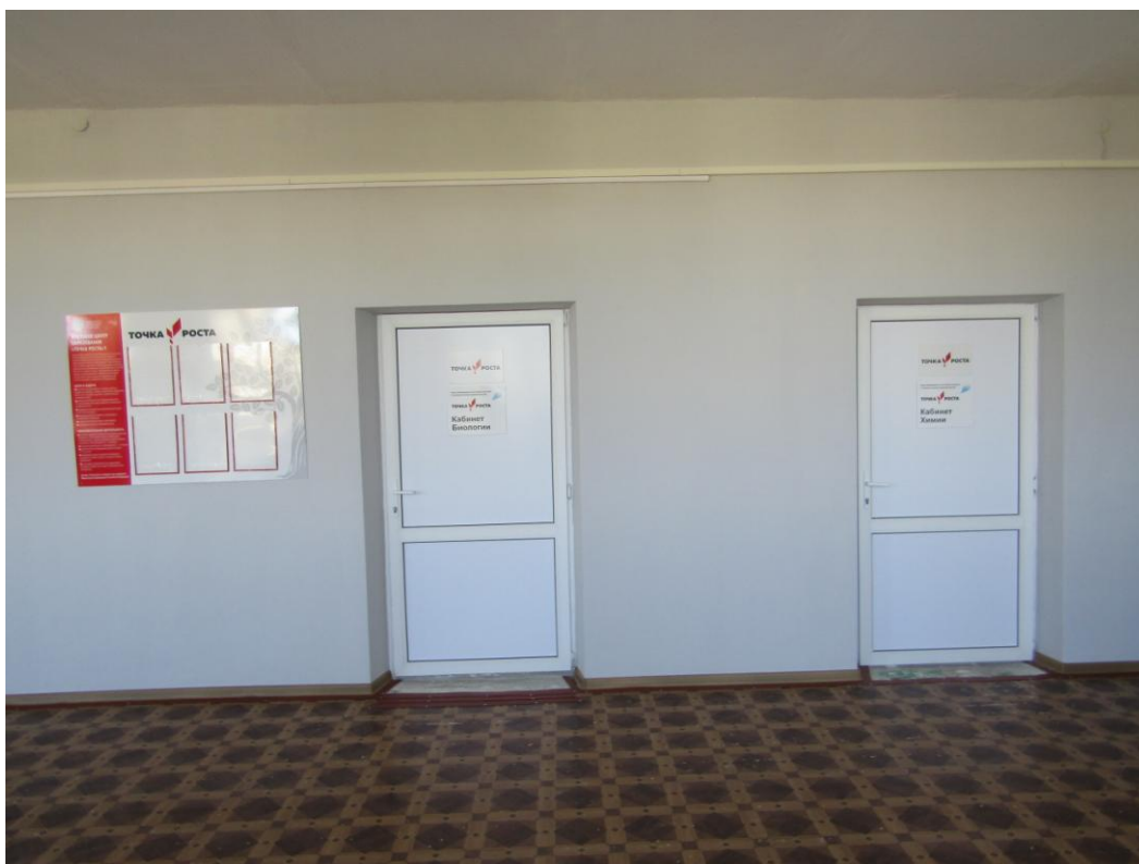
Ремонт «Точка роста»
