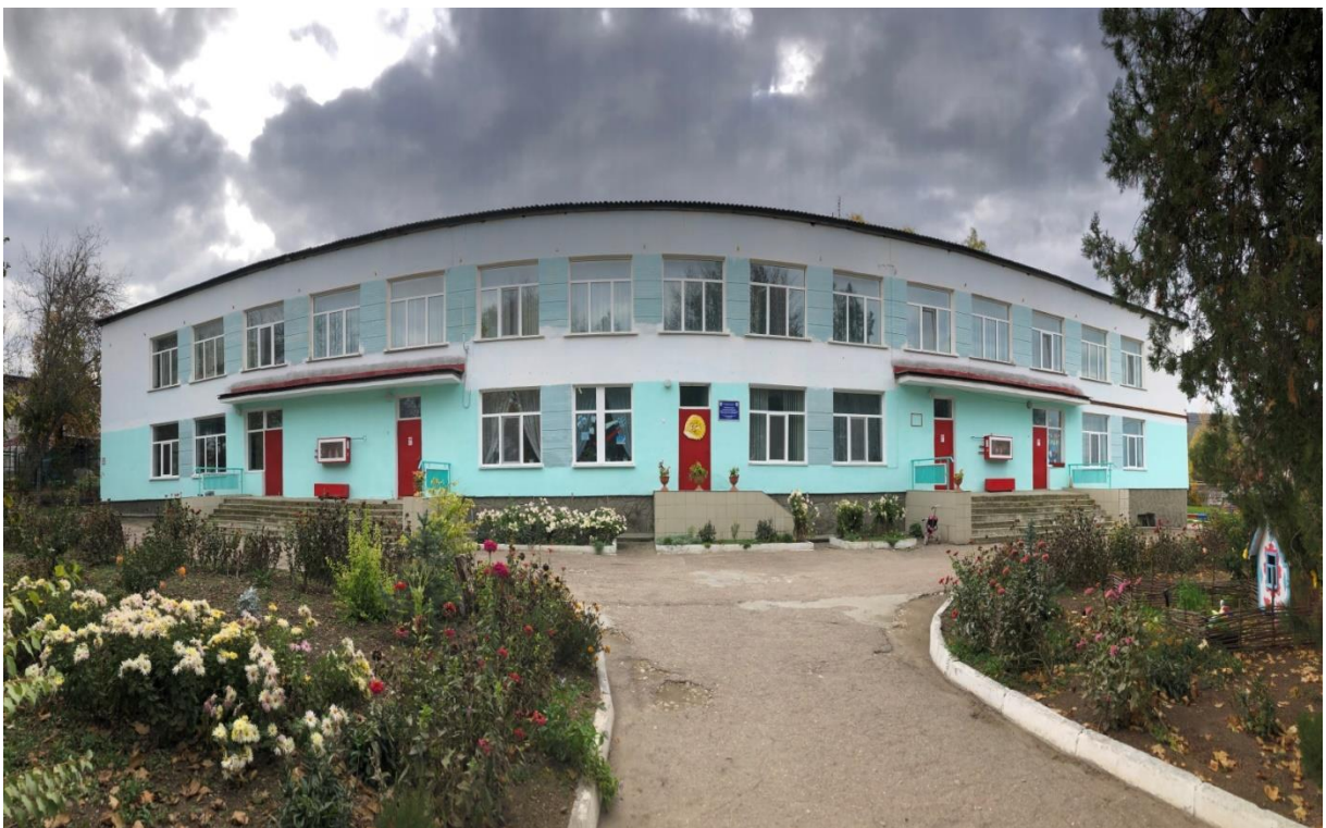
здание детского сада (общий вид)
