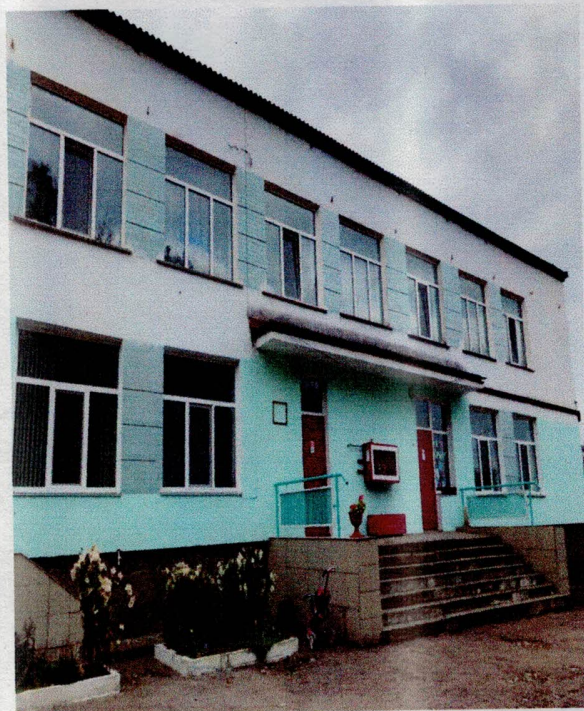
Лестница наружная – фото 4
