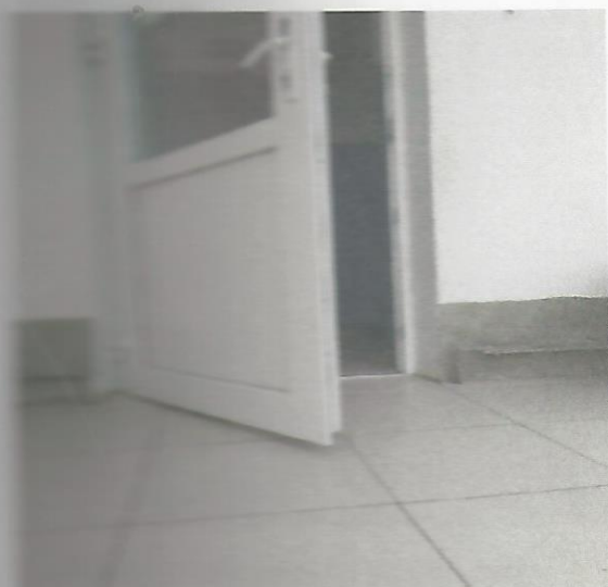
Фото № 11 Наружная входная дверь
