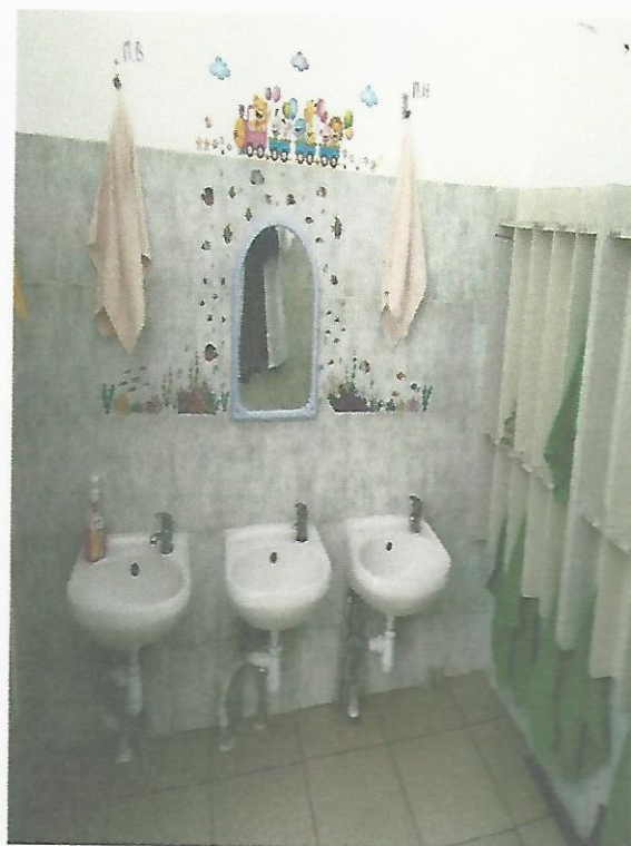
Фото № 24 Санитарно-гигиеническое помещение
