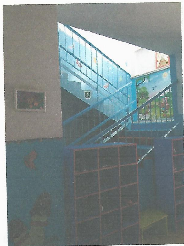
Фото № 14 – Пути движения внутри здания (внутренние лестницы)
