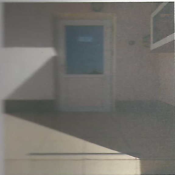
Фото № 7- Главный вход подъезд №1
