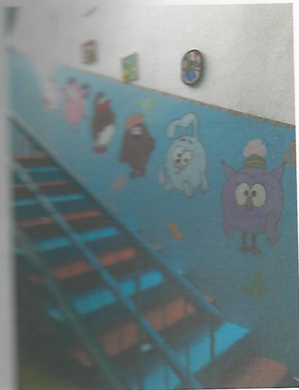
Фото № 13 – Тамбур и пути движения внутри здания (внутренние лестницы)
