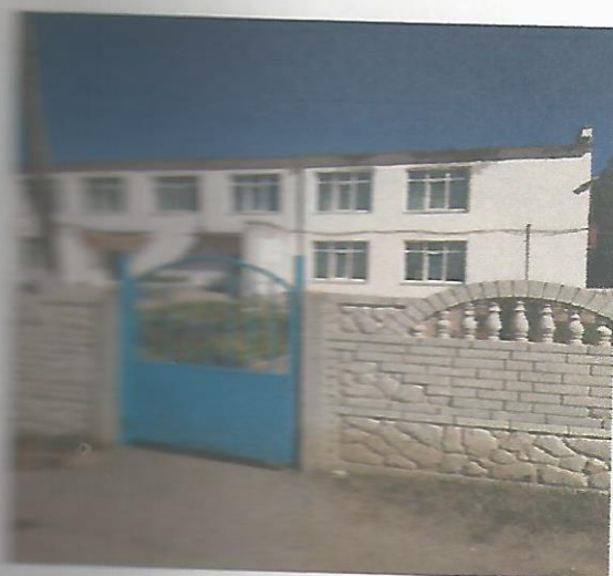
Фото № 3 Вход на прилегающую территорию
