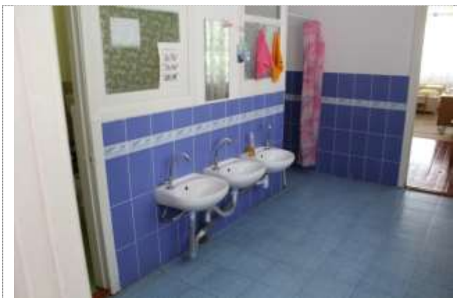
Фото № 15 (а) – Санитарно-гигиеническое помещение
