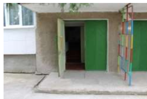
Фото № 11 (в) – Пути эвакуации
