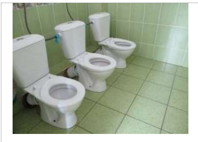
Фото № 15 (в) – Санитарно-гигиеническое помещение
