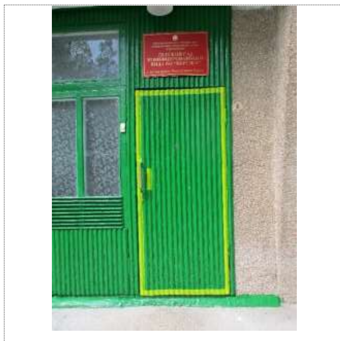
Фото № 6 – Дверь (входная)
