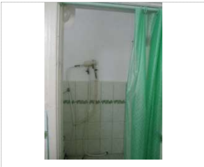
Фото № 16 (в) – Душевая комната
