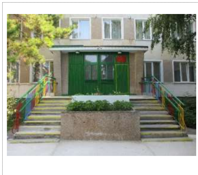
Фото № 4 – Вход в здание (лестница наружная)
