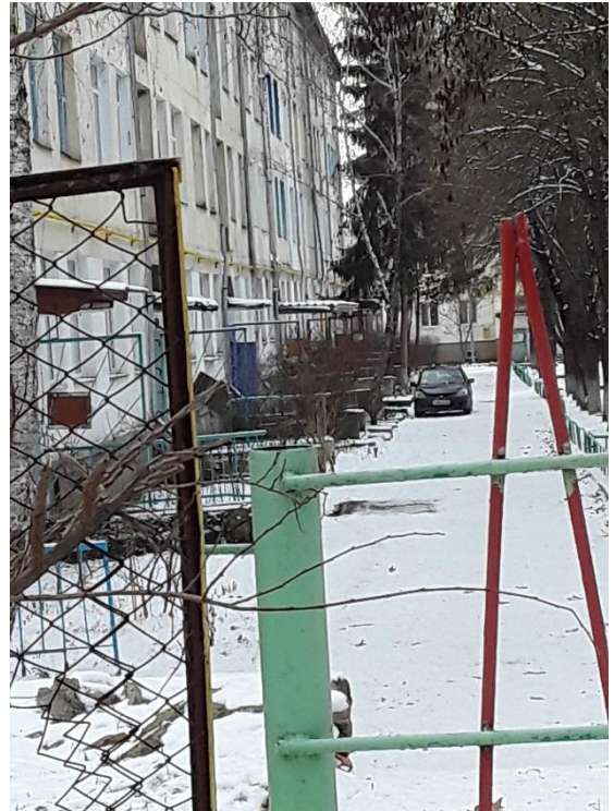
Слева от здания ул. Садовая 3 2.2
