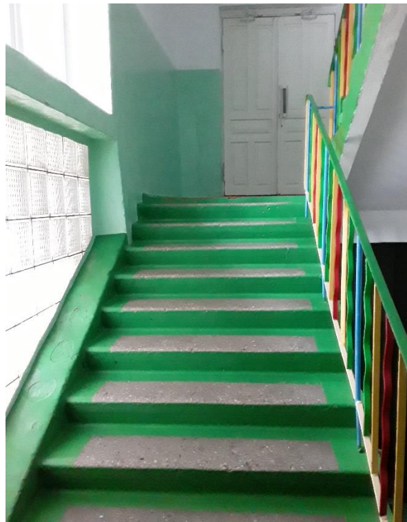
Лестница при входе на II этаж 7.2
