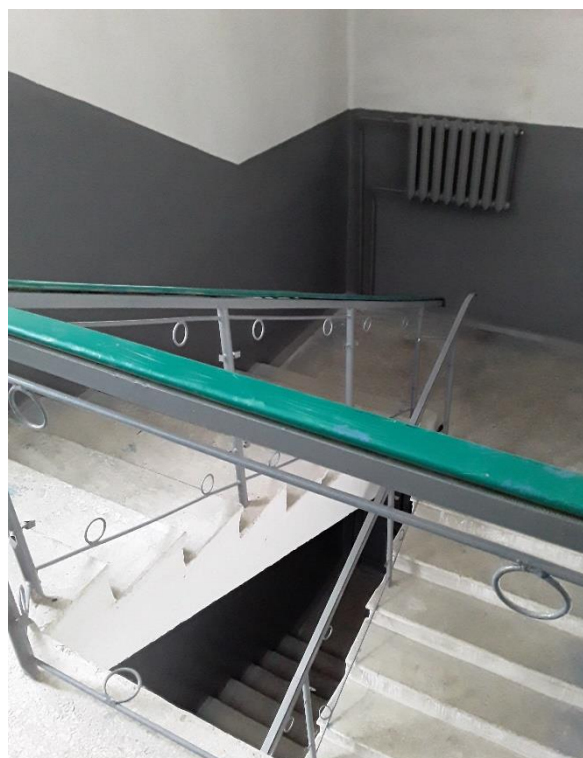
Лестница запасной выход 7.4
