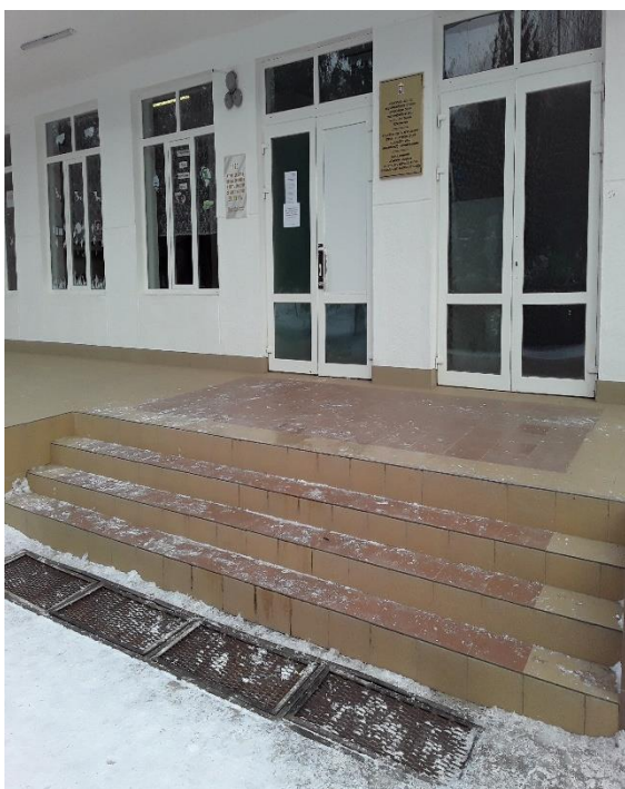
Вход в здание 10.2
