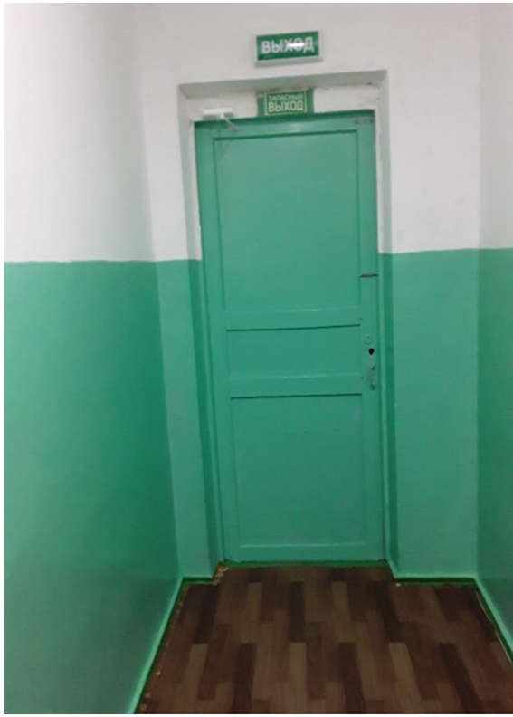
Запасной выход I этажа из коридора 6.1
