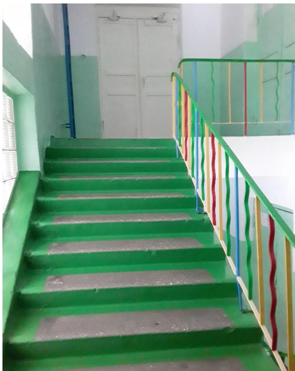
Лестница при входе на III этаж 7.3
