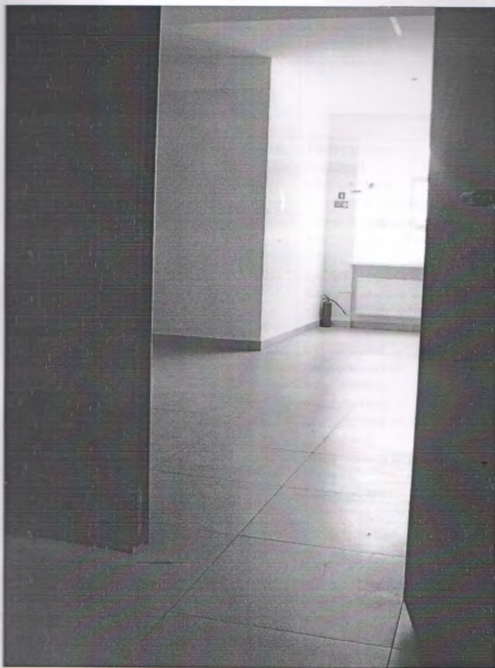
п.3.3. (Двери на 1,2,3 этаже) правое крыло – фото № 456
