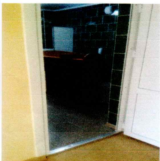
41 – дверь в санузел
