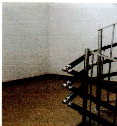
30 – лестница на 2 этаж
