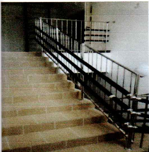
31 – лестница на 2 этаж
