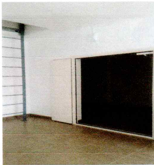
32 – лестничная площадка, 2 этаж
