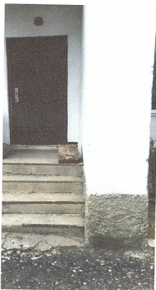
Фото 20- Путь эвакуации (муз.зал)
