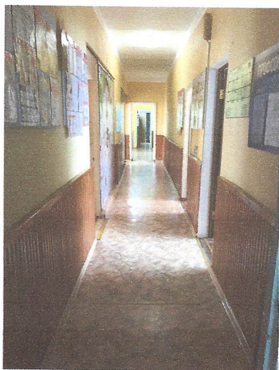
Фото 12 – Коридор 1 этаж (путь эвакуации)
