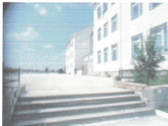
1.2. Возвышенность на пути к зданию школы
