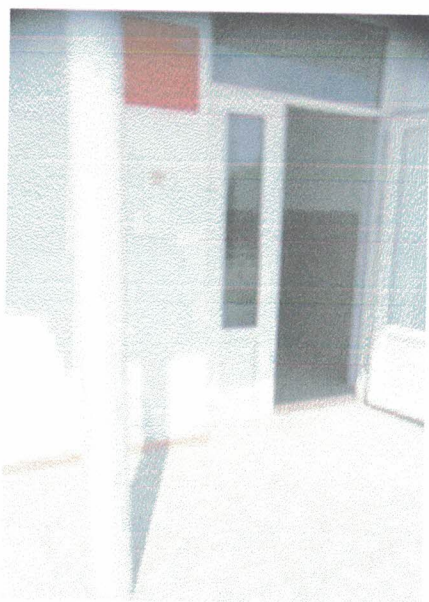
2.3.Входная дверь в здание школы
