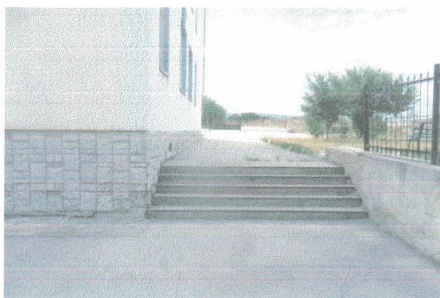
1.6. Ступенчатый спуск на территорию школы (задняя часть здания)
