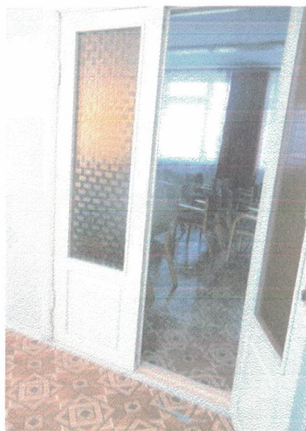
5.6. Вход в актовый зал
