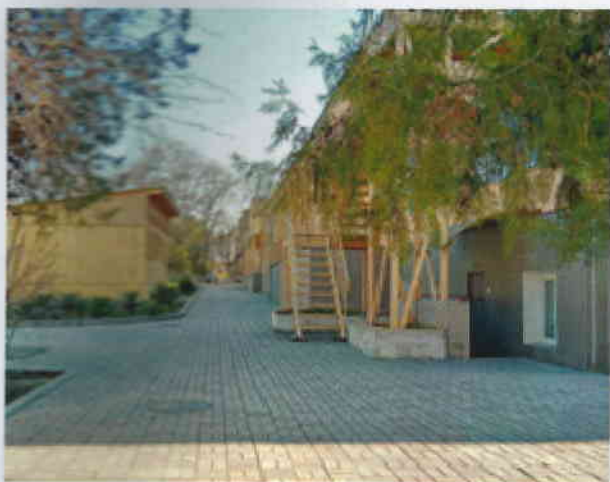
Фото № 3- Прилегающая территория пути эвакуации
