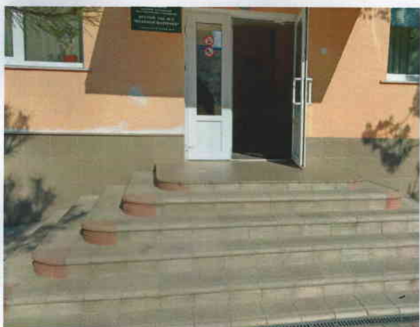
Фото № 5- Главный вход подъезд №1
