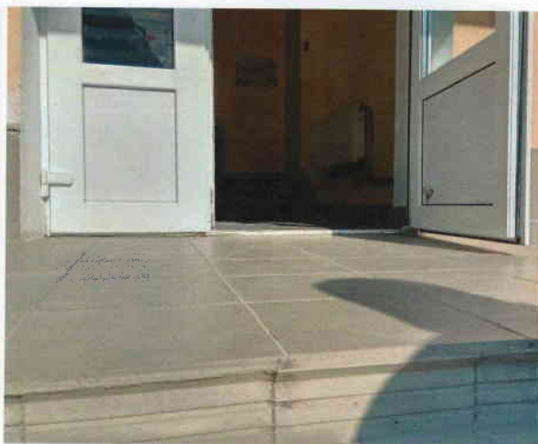
Фото № 8 Наружная входная дверь
