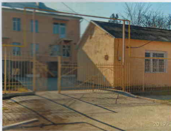
Фото № 1 Вид на прилегающую территорию
