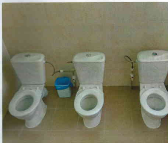
Фото № 21 Санитарно-гигиеническое помещение
