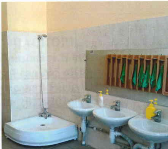
Фото № 22 Санитарно-гигиеническое помещение
