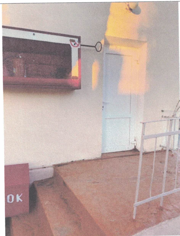
Фото №10 Пути эвакуации
