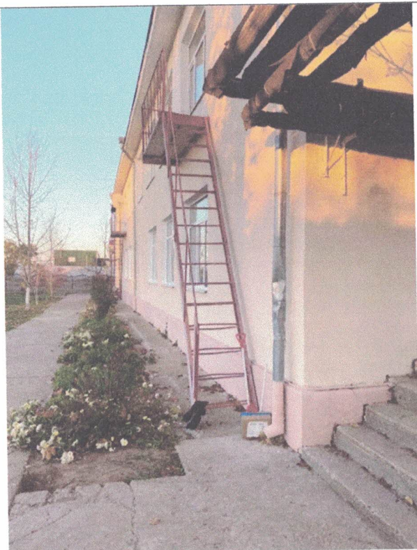
Фото №9 Пути эвакуации
