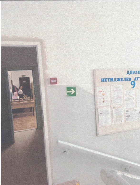
Фото №13 Пути эвакуации
