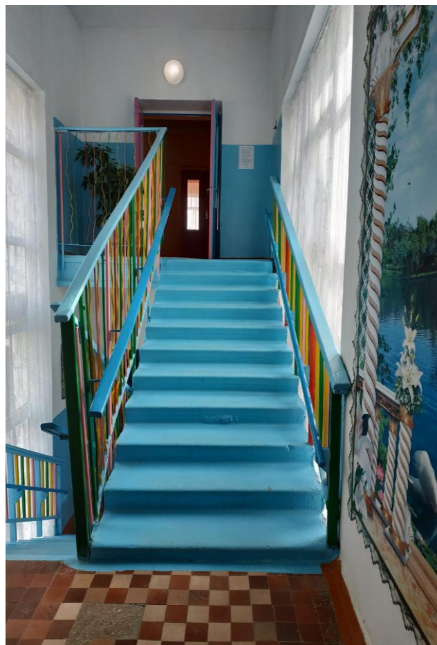
14. Лестница на 2 этаж
