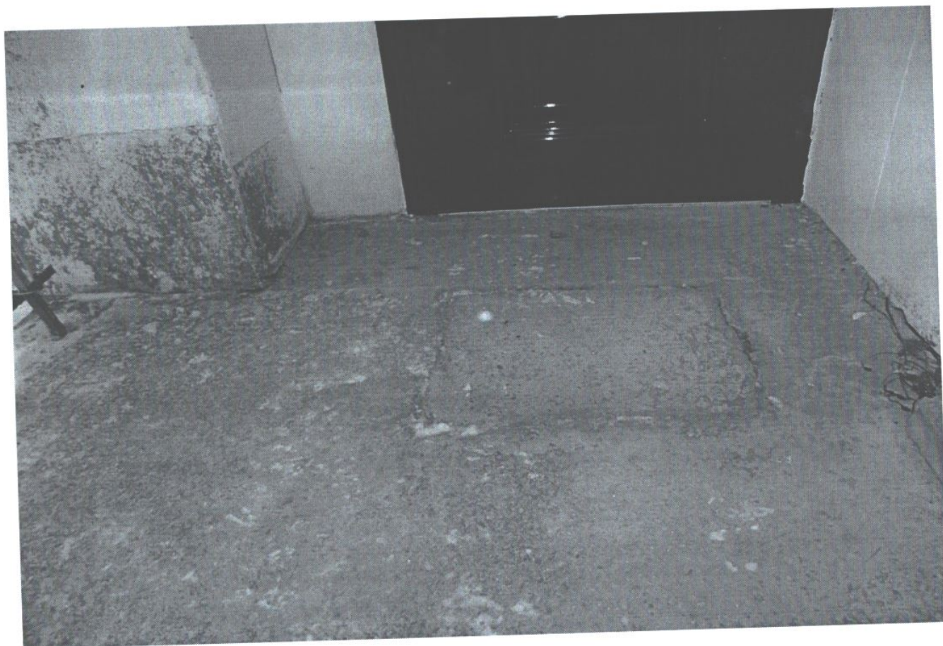
Фото 10. Входная площадка перед дверью
