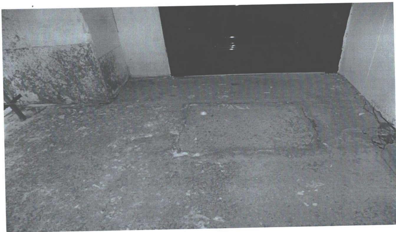
Фото 8. Входная площадка перед дверью
