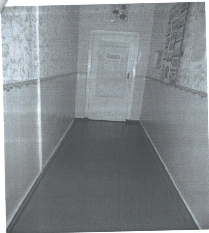
Фото 18. Коридор (вестибюль, зона ожидания, галерея, балкон)
