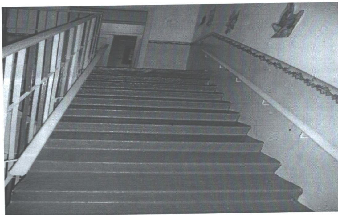
Фото 22. Лестница (внутри здания)
