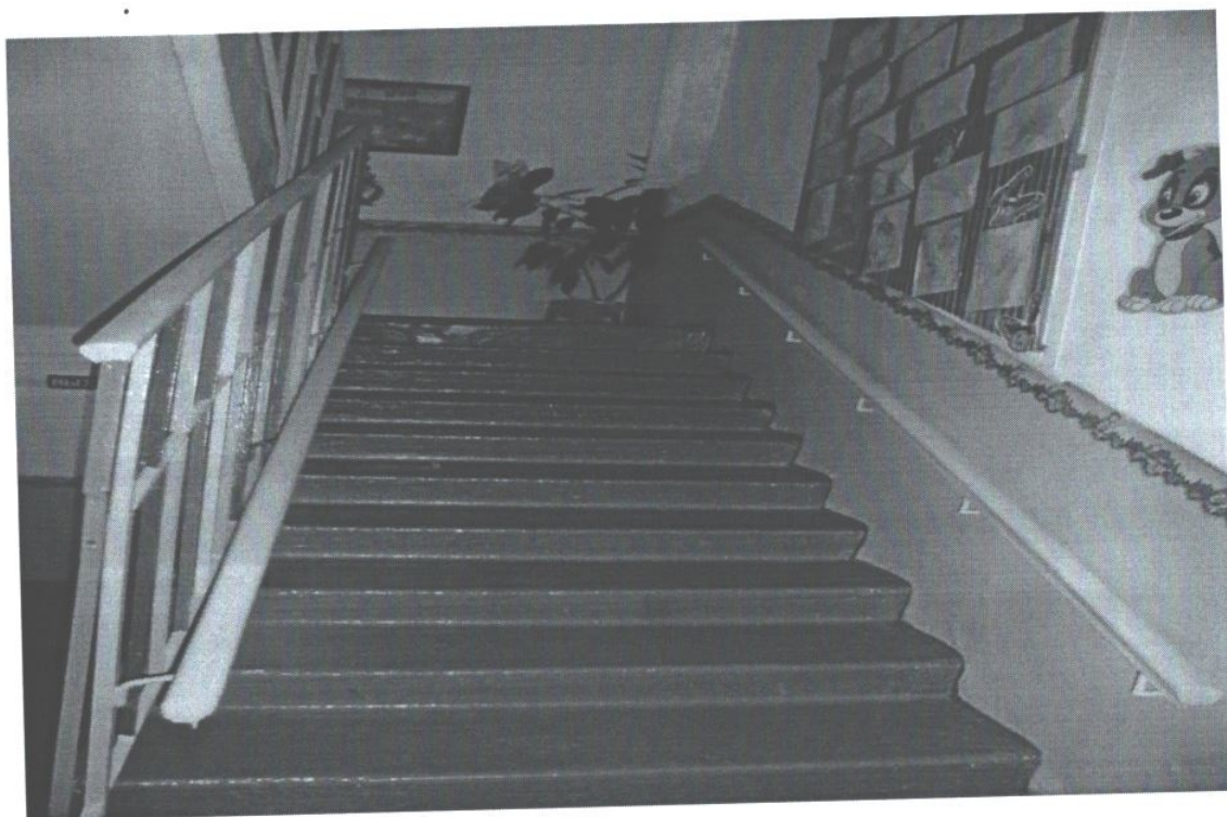
Фото 21. Лестница (внутри здания)
