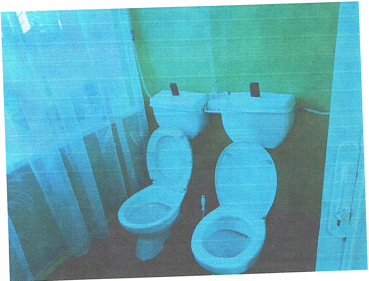
Фото №18 Туалетная комната
