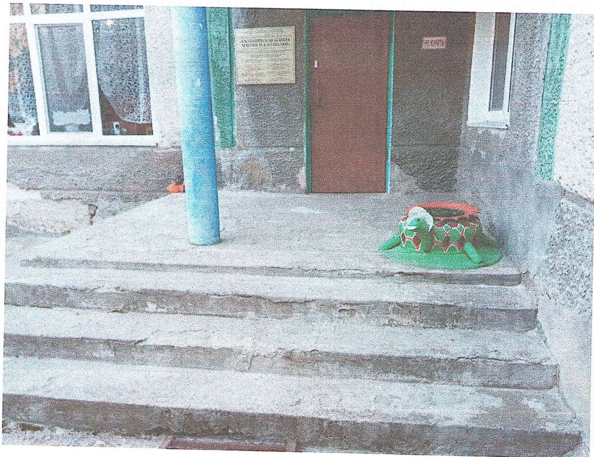
Фото №5 Входная площадка перед центральным входом
