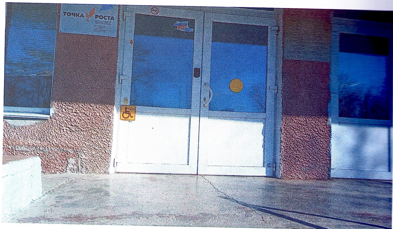
Фото №6 Входная площадка перед центральным входом
