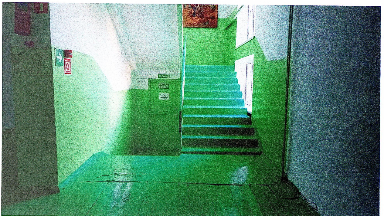
Фото № 13 Вход на лестницу внутри здания
