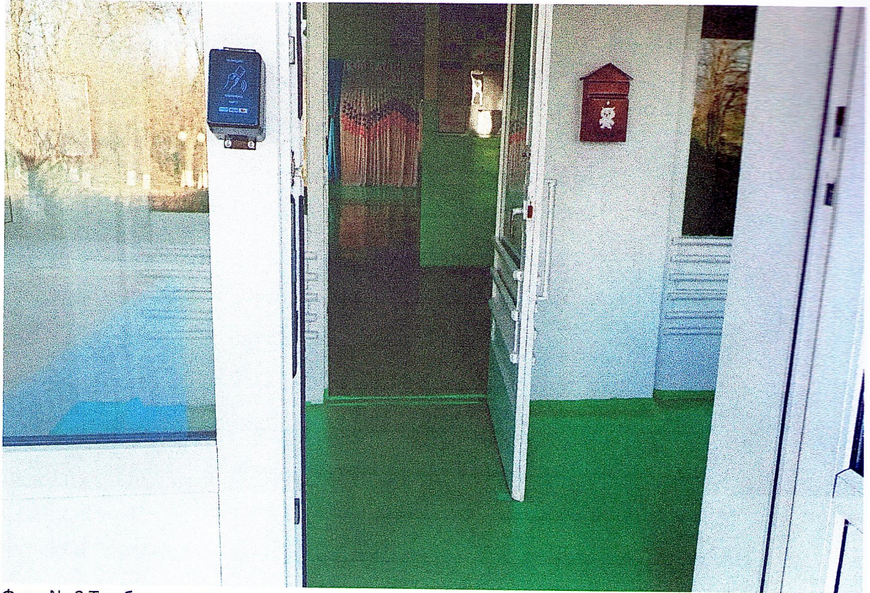
Фото № 8 Тамбур с центрального входа
