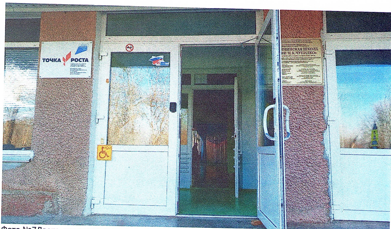
Фото №7 Дверь входная с центрального входа
