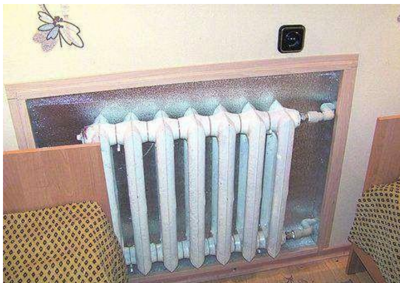
Пример установки теплоотражающего экрана
