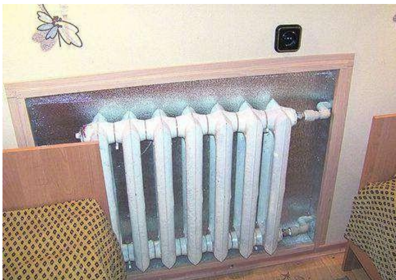
Пример установки теплоотражающего экрана
